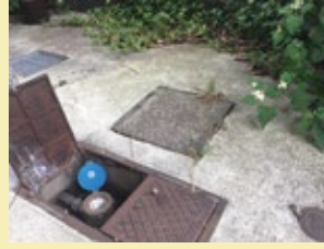
水道メーターのチェック
