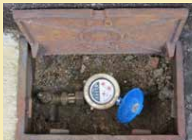
水道メーターのチェック
